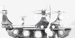
Измерительная машина, 1908 год. Отсчет по нониусу 1/10000 мм
